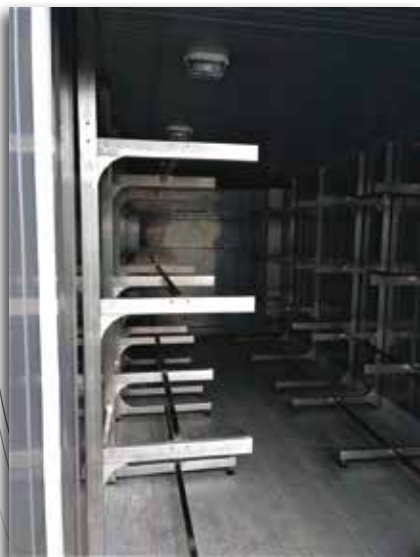
Aménagement intérieur conteneur.
