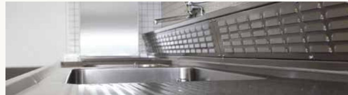
**Wandabsaugung.** Rückwärtige Wandabsaugung mit garantiert gleichmäßiger Absaugwirkung auch bei langen Arbeitstischanlagen durch Installation eines zusätzlichen Untertischkanals mit mehreren Abgängen an den rückwärtigen Wandkanal.
