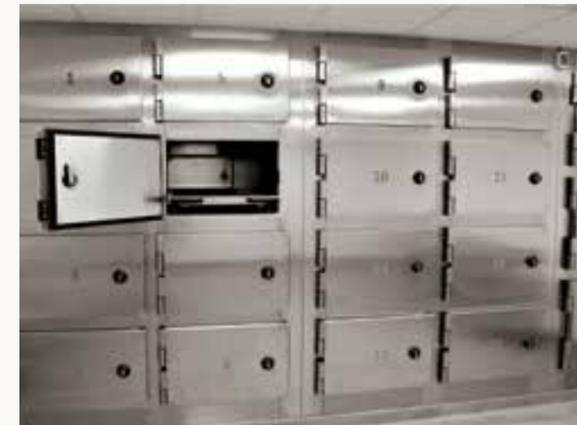
**Elektronische Schließanlage** für eine oder mehrere Kühlzellen mit unterschiedlichen Funktionen, angefangen von der Zugriffskontrolle bis hin zu kompletten Systemlösungen zur Überwachung der Kühlzellen.
