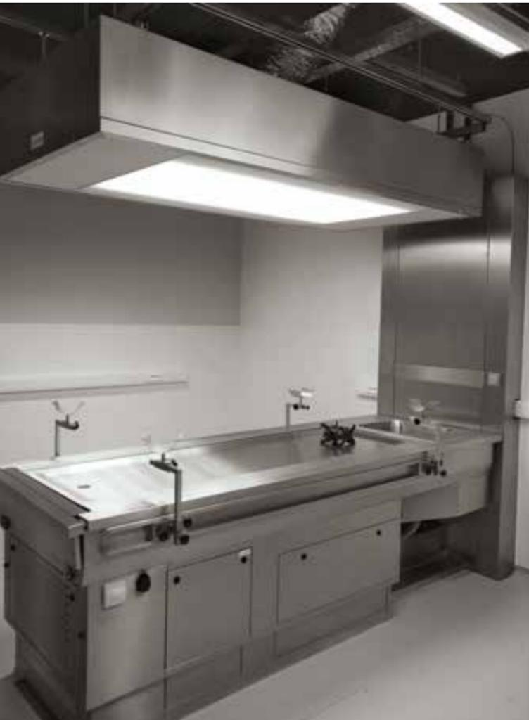
Seziertisch mit Wechselsystem für 2 unterschiedliche Muldengrößen und integriertem Aktivkohlefilter.
