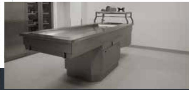
**F** Arbeitstischanlage mit Becken, abgesaugter Arbeitsfläche, Formalinausguss und Müllabwurfschacht.
